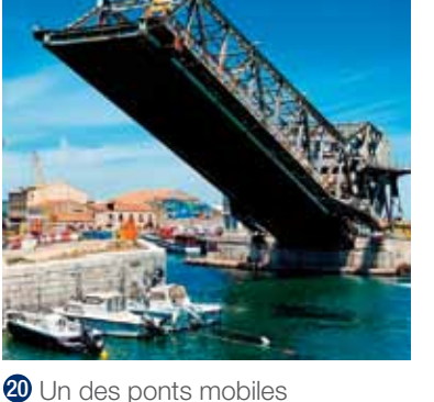
20 Un des ponts mobiles
