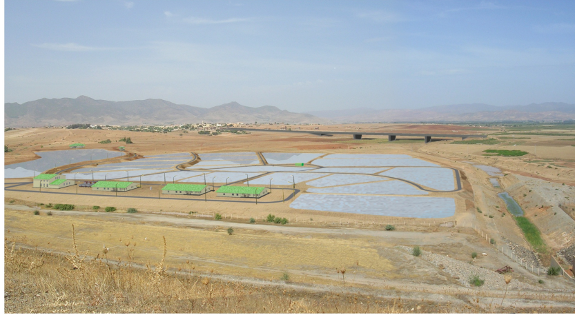
PROJET BARRAGE DE HARREZA
